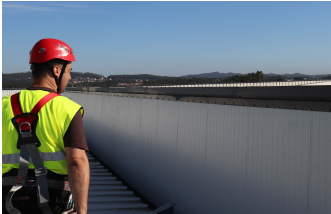
Trabalhos em Altura | Height Level Work
